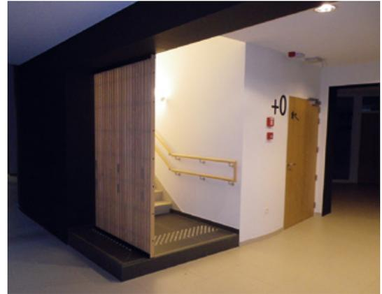
**Foto 3:** Die Treppen sind ausgestattet mit doppelten Handläufen und Beleuchtung. Eine kontrastreiche Gestaltung und taktile Markierungen sichern die Stufen. (© TGB 2013)
